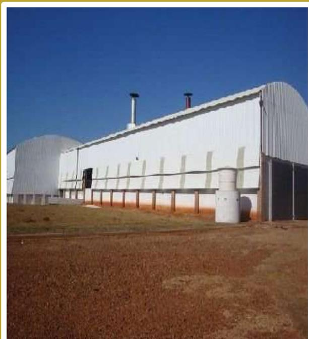
A construção da Fábrica em Pien-Pr iniciou em 2010 em produção no final de 2012 com capacidade instalada para até 90.000 toneladas de pellets de madeira por ano. A Timber produz pellets de madeira, um bicomcombustível sólido renovável a base de madeira desidratada e compactada em forma de um granulado cilíndrico. Além de renovável e ambientalmente correto, o pellet de madeira é econômico e competitivo quando comparado a outros combustíveis fósseis como o óleo diesel, GLP e gás natural
